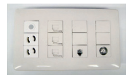
壁にLANケーブルの差込口があります。
